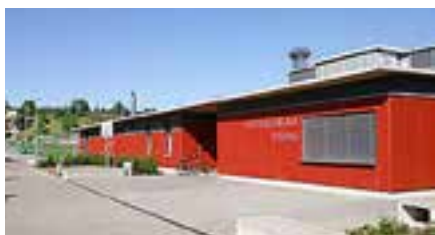
Bâtiment vestiaire Stighag, Kloten - vestiaires - armoires de vestiaire
