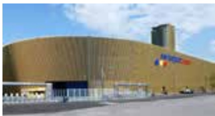
SwissporArena, Lucerne - vestiaires - armoires de vestiaire
