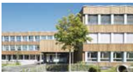
Ecole Säget, Jegenstorf - vestiaires
