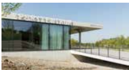
Centre sportif Eselried - vestiaires
