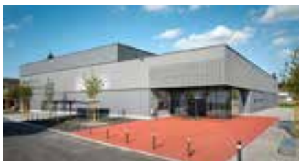
Construction d'une salle de gymnastique triple, Schötz - vestiaires - panneau d'affichage
