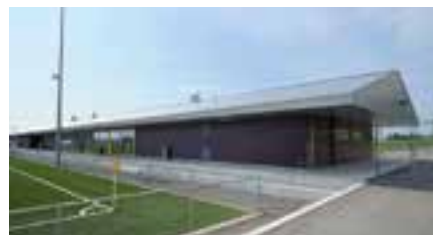
Centre sportif, Boudry - vestiaires
