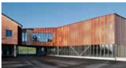
Salle de gymnastique double, Auw - vestiaires
