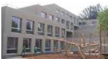
Ecole Unterlöchli, Lucerne - vestiaires
