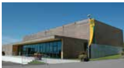
Mehrzweckhalle, Neuheim – Garderoben
