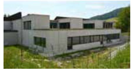
Schulhaus Steinboden, Eglisau - Garderoben
