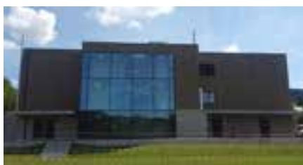
Erweiterung Schulanlage, Arisdorf - Garderoben
