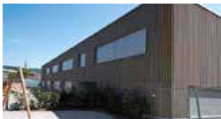
Schulhaus Breiteacker, Pfungen - Garderoben
