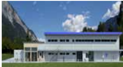
Garderobengebäude, Domat/Ems – Garderoben – Wertsachentresore
